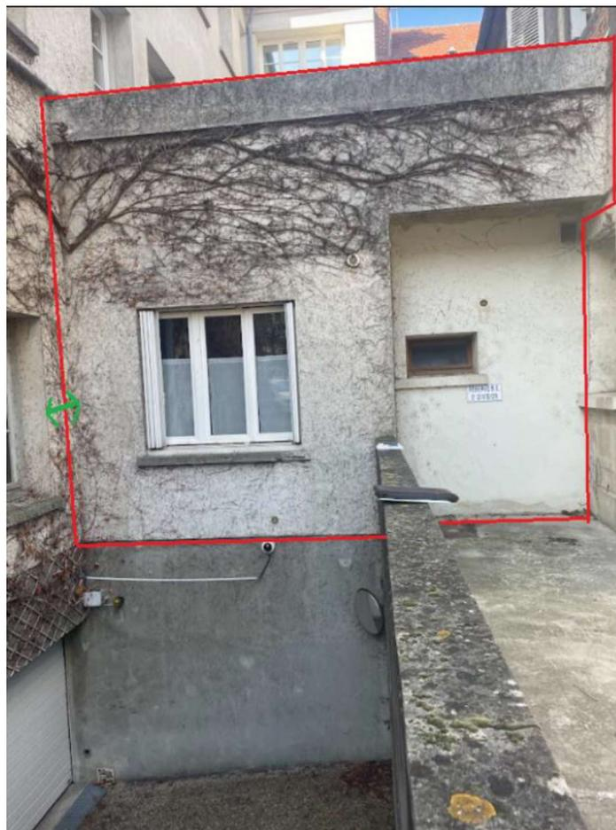
Projet d'isolation thermique par l'extérieur avec isolant polystyrène gris 120mm.
