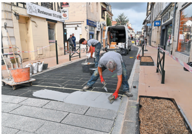
Les travaux de la rue de Pierrefonds
