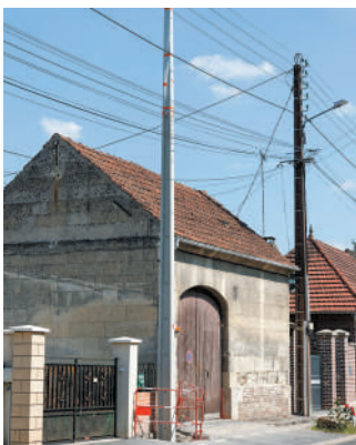
Les nouveaux poteaux électriques
