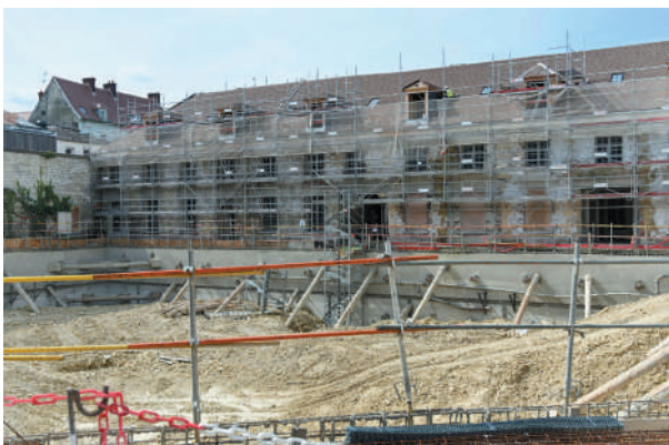
Visite du chantier du programme François 1 er , rue de la 8 ème Division
