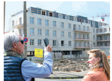
Visite du chantier de l'Estacade avant l'arrivée des nouveaux habitants
