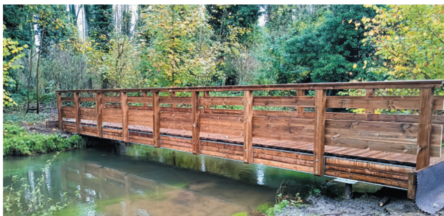
La nouvelle passerelle en bois pour franchir l'Automne
