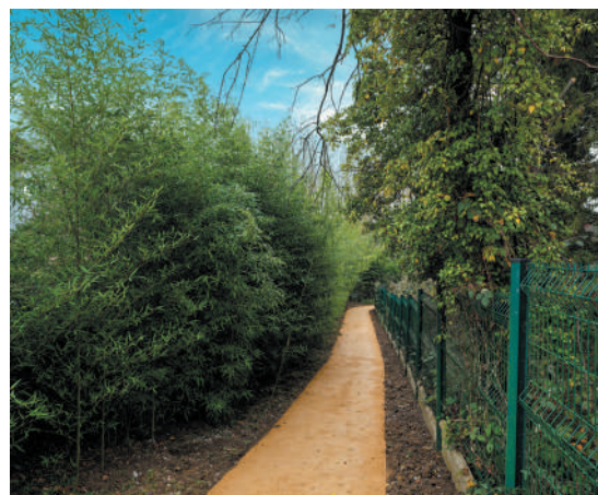
Aménagement de la sente piétonne du parvis de l'église à la rue Adrien Debuire desservant la salle multifonction
