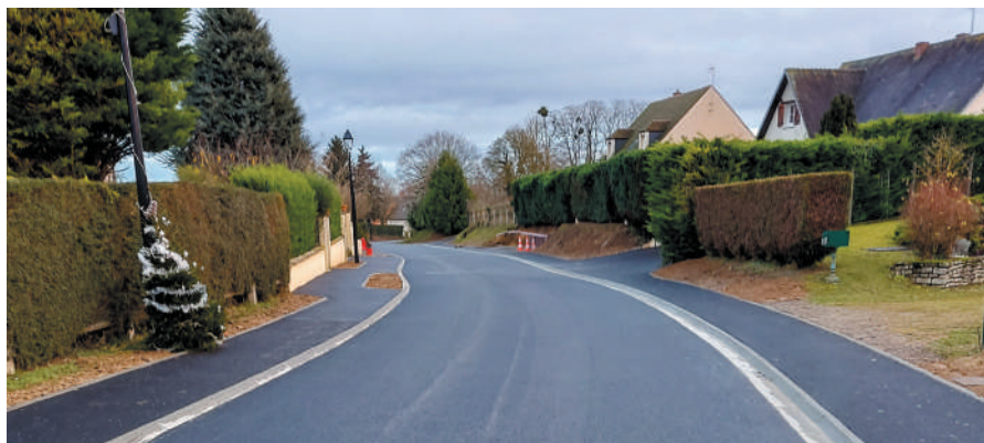
Enfouissement des réseaux électriques rue de la Plaine
