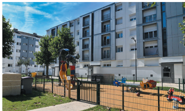
Le square du Vivier Corax a bénéficié de travaux de rénovation
