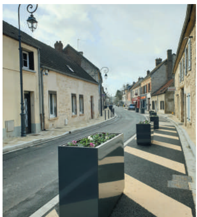
Réfection rue Saint-Pierre
