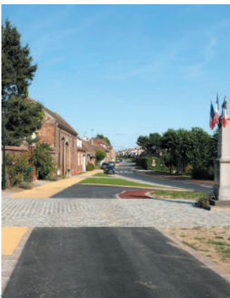
Réfection des trottoirs
