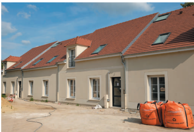
De nouvelles habitations ont vu le jour à Bienville
