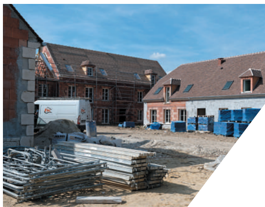
La construction des nouveaux logements de l'OPAC
