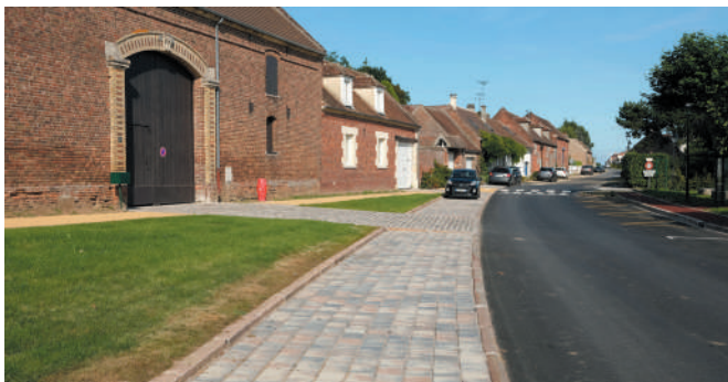
Réfection des trottoirs et réorganisation des espaces de circulation pour tous
