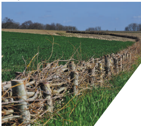
Aménagement de fascines pour lutter contre les ruissellements de boue
