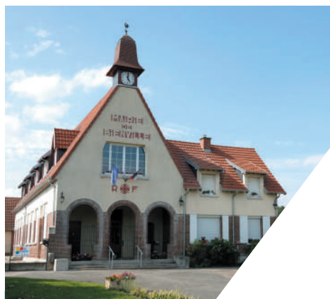
La Mairie et l'École ont bénéficié d'une toiture neuve
