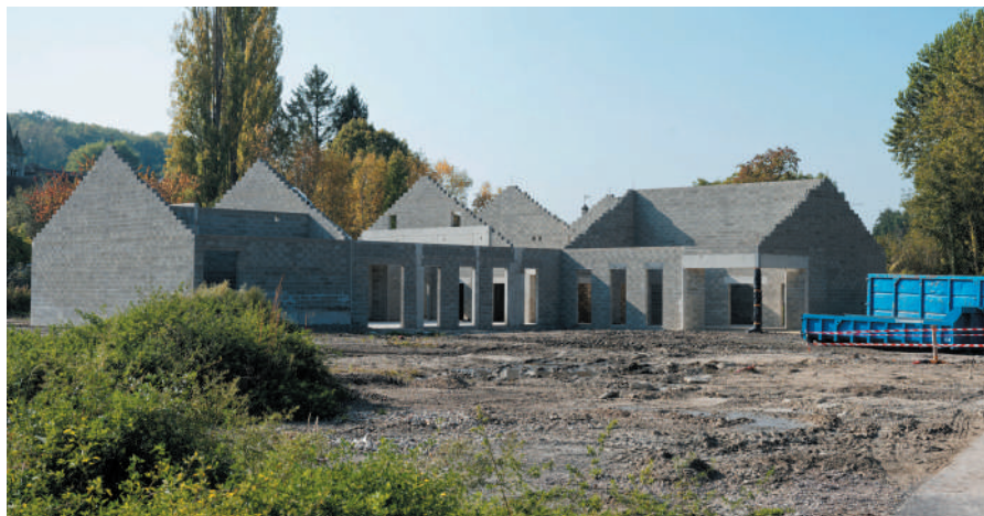
La salle intercommunale en cours de construction sera achevée en avril 2022
