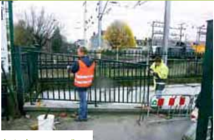
Travaux du passage souterrain
