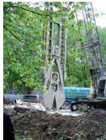
Construction du bassin d'orage place du 5 ème Régiment de Dragons
