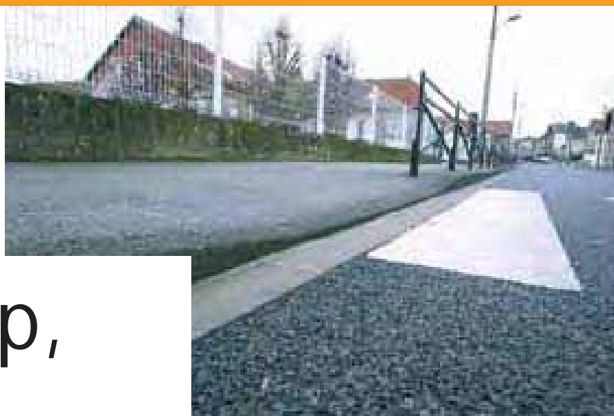
Voirie surbaissée pour faciliter le déplacement des personnes en fauteuil roulant
