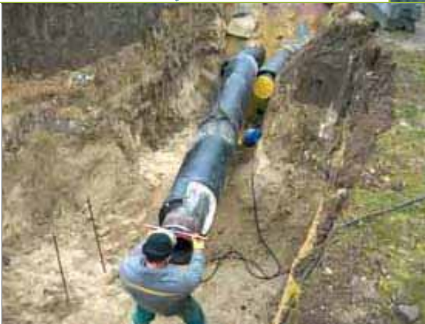
Rénovation des canalisations du chauffage urbain
