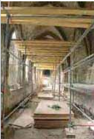
Les galeries du cloître Saint-Corneille en cours de restauration
