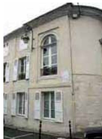
Maison historique rue de Paris, récemment restaurée avec le concours de la ville
