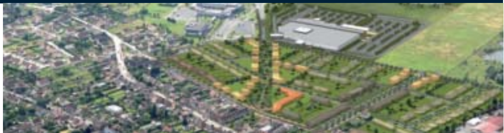
De gauche à droite : le chantier du Clos Féron à Le Meux, La Croix Saint Ouen, vue aérienne
