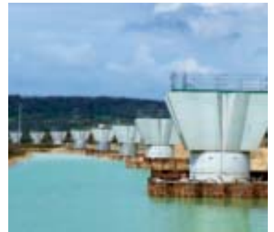
Le futur viaduc de la rocade nord-est
