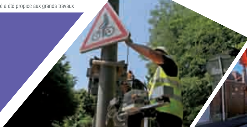
> Tests de mise en conformité des candélabres
