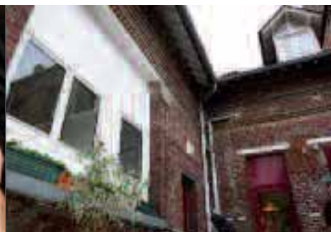
> De nouvelles fenêtres en PVC au Foyer Pasteur
