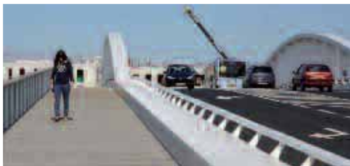
> Mise en circulation du Pont Neuf le 12 septembre 2011
