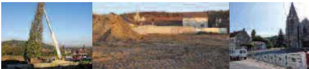
> Travaux du centre-bourg
