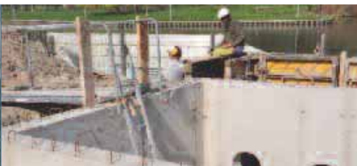
> La finition du bassin d'orages de la rue de l'Oise
