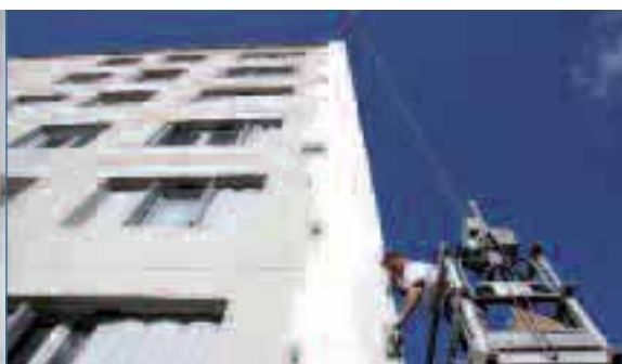
> Des travaux pour réduire la consommation d'énergie à la résidence Marie-Caroline
