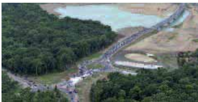
> Le bassin de rétention de Choisy-au-Bac sous la rocade nord-est
