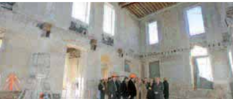
> L'ancien hôpital Saint-Joseph en travaux
