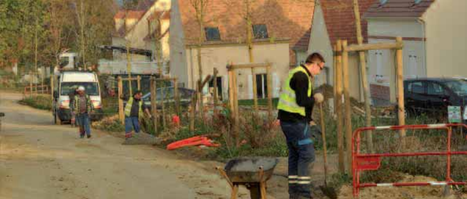
> Les travaux d'aménagement du Clos Féron à Le Meux
