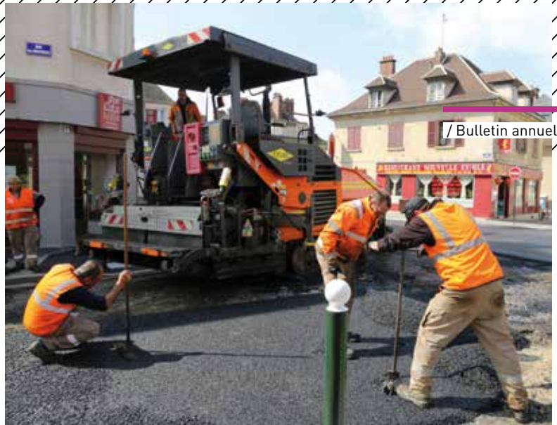
Les travaux de voirie rue du Change pendant l'été
