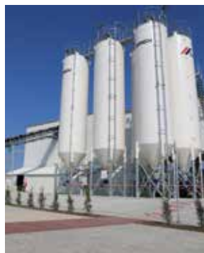
La centrale à béton du port fluvial
