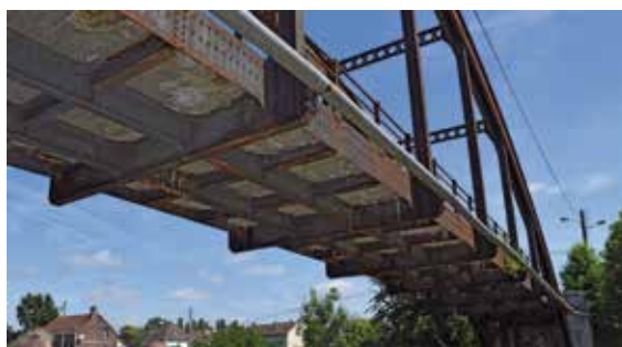
Le pont de Janville, un sujet majeur
