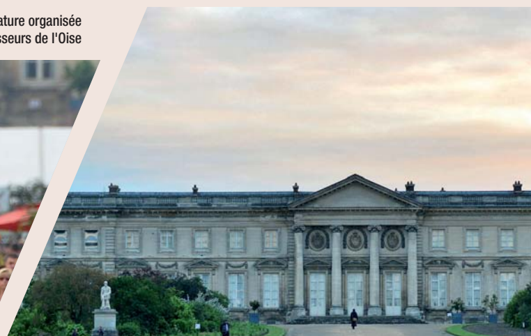
Le Palais impérial s'adapte aux personnes à mobilité réduite avec l'aménagement d'une rampe d'accès et d'un ascenseur
