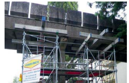
Travaux de consolidation de la passerelle
