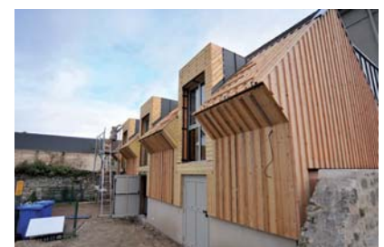
La mairie agrandie et réhabilitée
