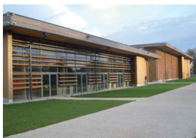
La nouvelle halle de sports
