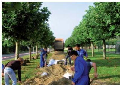
Pose de pavés en partenariat avec les collégiens de la SEGPA de Margny
