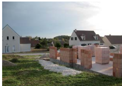
La construction du lotissement La Vallée
