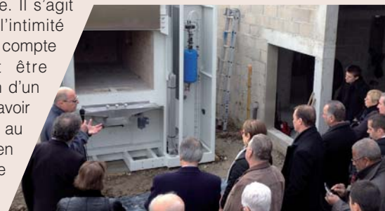
Visite de chantier lors de la pose du four du crématorium de Saint-Sauveur
