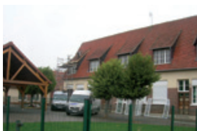
La mairie et l'école ont bénéficié de travaux d'isolation
