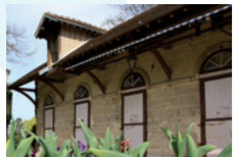
Ce bâtiment, attaché à l'Abbaye de Bayser, sera aménagé en 2013 pour accueillir la crèche familiale de l'Abbaye
