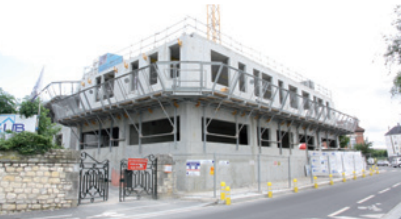
Construction du Centre d'études et d'expositions Antoine Vivanel sur les bords de l'Oise
