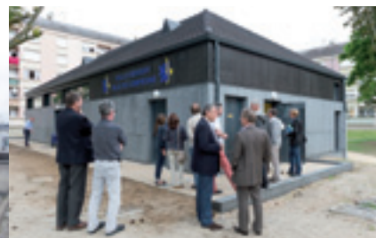
Réception des travaux pour la nouvelle salle de quartier
