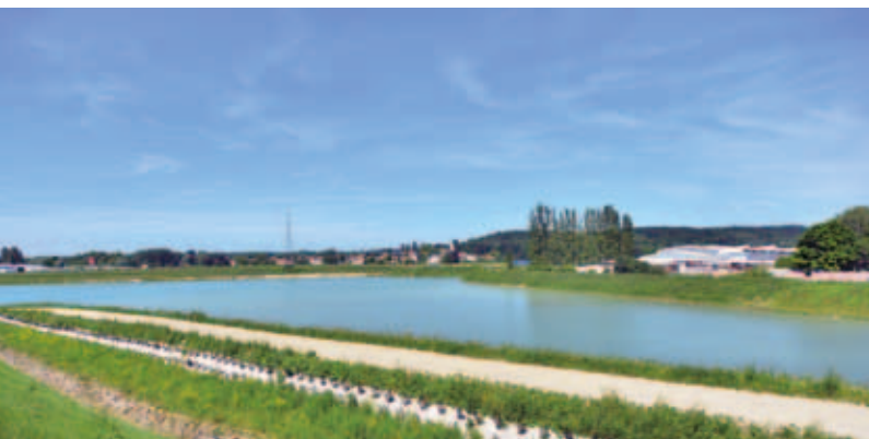
Aménagements de loisirs en cours de réalisation autour du bassin d'atténuation des crues de Choisy-au-Bac
