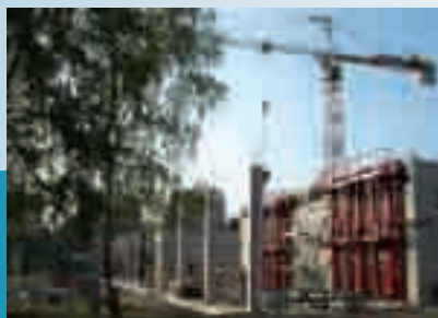
> Le Centre d'innovation de l'UTC en construction
