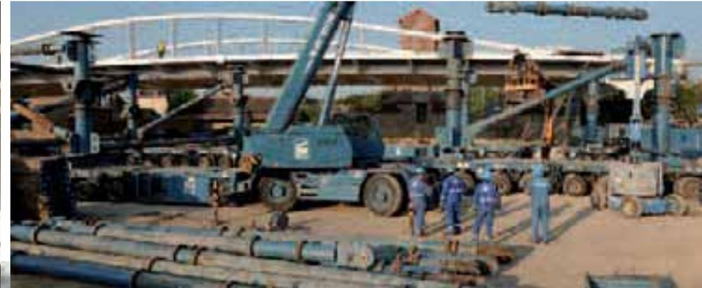
**12- Fin avril 2011** - Installation et assemblage des Kamags (grossemoteurs hydrauliques avec 8 à 10 lignes d'essieux) qui vont permettre le déplacement sur les barges des deux parties du tablier métallique. Celles-ci vont ensuite être mises en place sur leurs appuis par flottaison.
