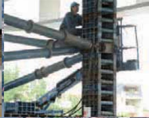
Dévrinage final (descente sur des vérins) de la 2<sup>ème</sup> partie de la travée du tablier métallique. Le tirant d'eau de l'Oise dans la passe non navigable étant trop faible, un dévrinage a été fait pour le poser sur ses appuis.
