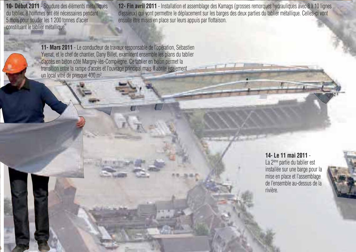
**14- Le 11 mai 2011** - La 2<sup>ème</sup> partie du tablier est installée sur une barge pour la mise en place et l'assemblage de l'ensemble au-dessus de la rivière.
