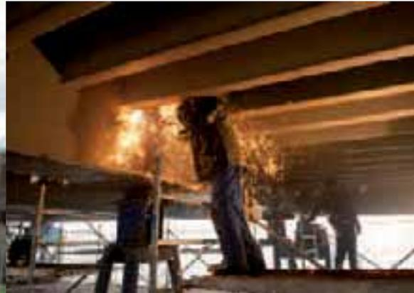
**10- Début 2011** - Soudure des éléments métalliques du tablier. 8 hommes ont été nécessaires pendant 5 mois pour souder les 1 200 tonnes d'acier constituant le tablier métallique.
