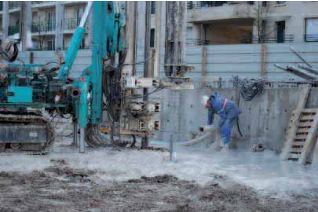
> Le chantier du bassin d'orages rue de l'Oise à Compiègne
