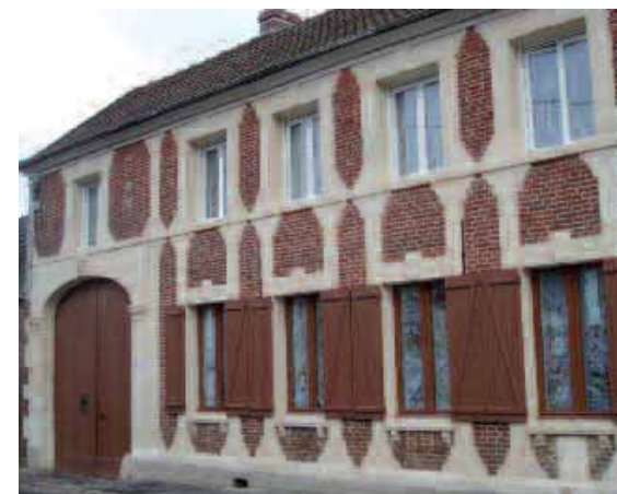
> Une façade réhabilitée à Jaux
