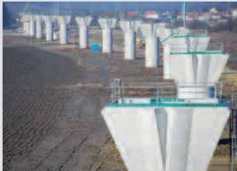
> Les piles du viaduc entre l'Aisne et l'Oise
