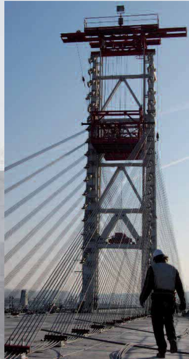
> Le mât de haubanage mesure 22 mètres, il permet d'assembler les voussoirs
