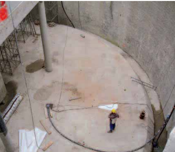
> Le chantier d'un bassin d'orages
