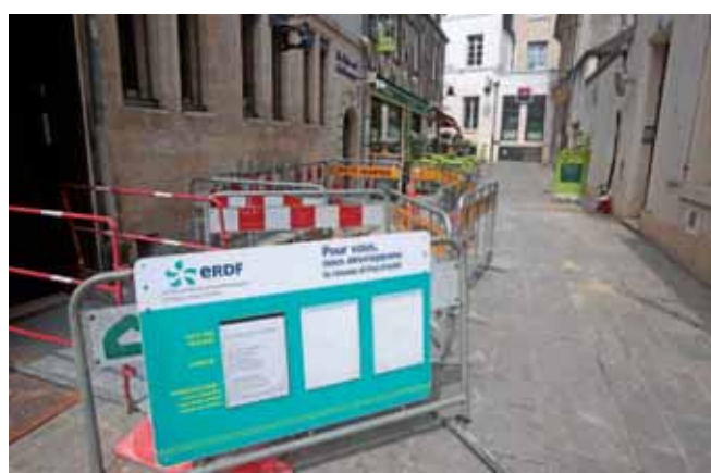
Le réseau basse tension a été rénové par la société ERDF dans les rues des Lombards, St-Martin, Napoléon et Cordeliers.
