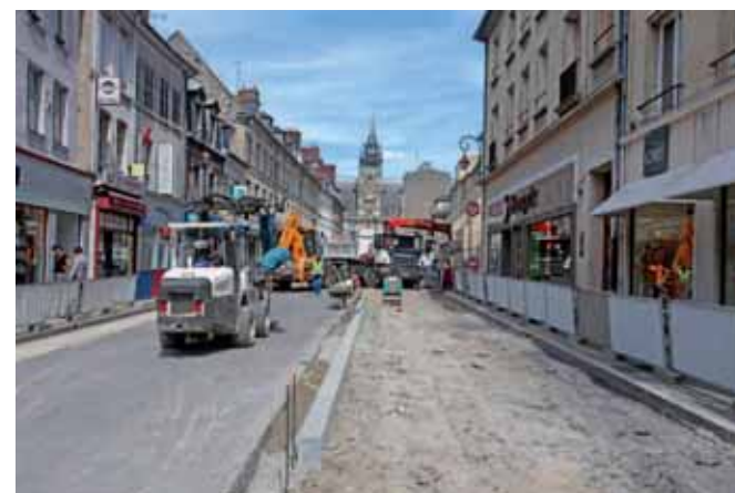
Travaux de requalification de la rue Saint-Corneille.
