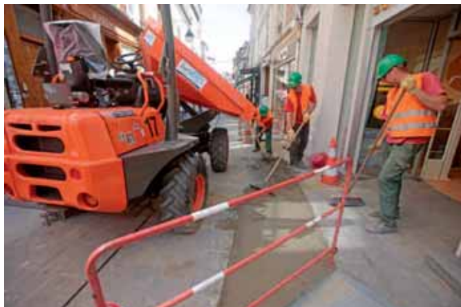
Reprise de branchements en plomb, rue des Lombards.
