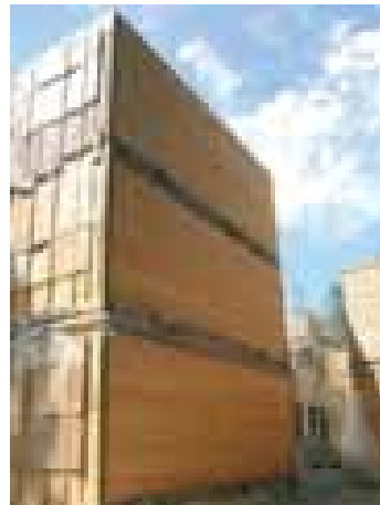
1 ère réalisation de ce type en France, la nouvelle résidence étudiante repose sur l'assemblage de modules en bois.
