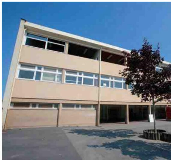
48 châssis de fenêtre de 4m de long ont été changés à l'école Robida A et B. Les châssis en aluminium sont dotés d'un double vitrage, isolant thermique et sonore. 24 classes donnant sur la cour sont concernées.
