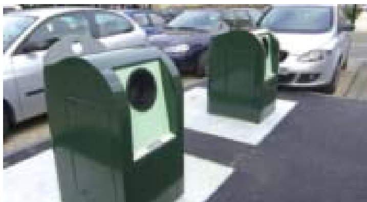
Des conteneurs à verre enterrés ont été installés rue Jeanne d'Arc.
