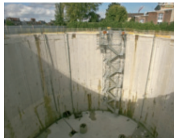
Bassin d'orages, rue de l'Oise.
