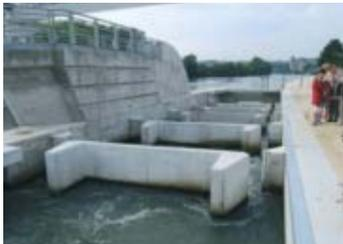
Le barrage de Venette sera similaire à celui de Verberie avec un système de régulation à clapets et une passe à poissons. (ici en photo)
