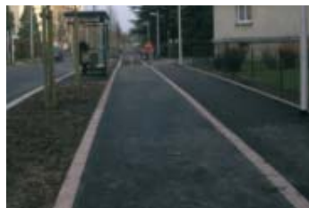
La toute nouvelle piste cyclable, boulevard des Etats-Unis.
