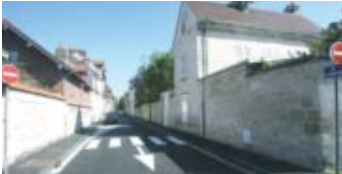
Réfection de la chaussée et des trottoirs, rue de la Madeleine.
