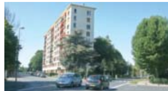
Un mini-giratoire sera prochainement réalisé, boulevard des Etats-Unis.
