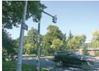
Aménagement d'un feu tricolore, route Forestière du Moulin.
