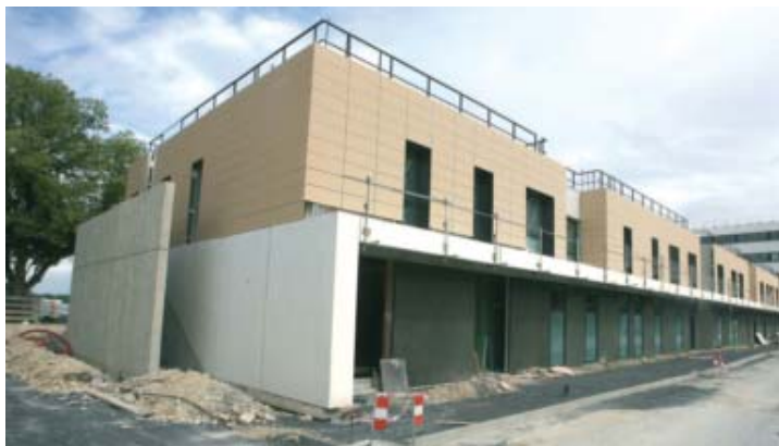
La construction de la nouvelle polyclinique Saint-Côme est en voie d'achèvement.
