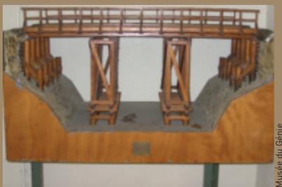
Maquette d'un pont de charpente.
