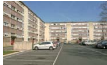
Aires de stationnement entièrement rénovées, square Lyautey.
