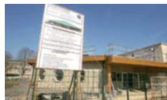
Construction d'un nouveau restaurant scolaire à proximité de l'école Robida.
