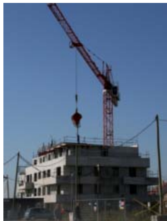
Compiègne poursuit sa rénovation urbaine. Ici, le quartier du camp de Royallieu prend son nouveau visage
