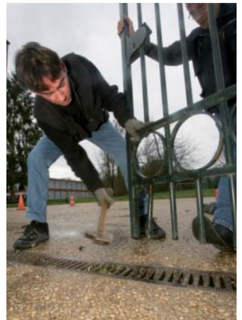
Les ferronniers redressent un pied de la grille d'entrée du Tennis Pompadour.
