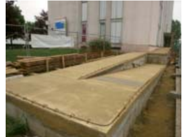
Réalisation d'une rampe d'accessibilité pour les personnes à mobilité réduite habitant l'immeuble "Les Roîtelets".
