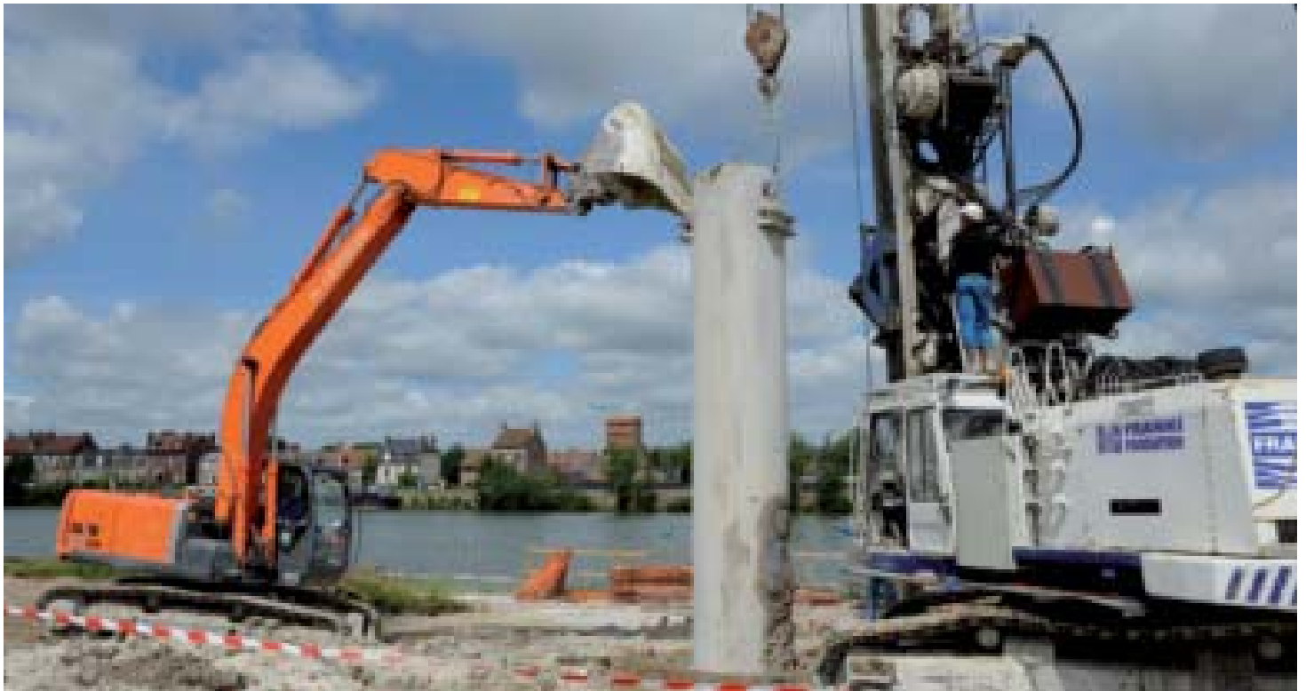
Rive gauche, les fondations du nouveau pont urbain sont en cours de réalisation
