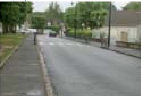
Rue de Stalingrad, 390 000 euros de travaux de voirie seront réalisés.
