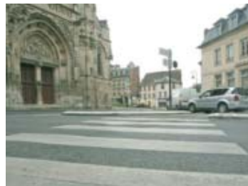
Travaux d'accessibilité pour les personnes à mobilité réduite, place St-Antoine.
