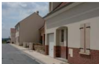
A terme, 600 logements sur la ZAC du Camp de Royallieu.
