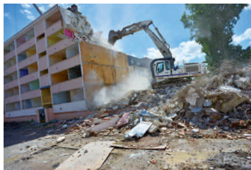
Démolition de l'immeuble square Gérard de Nerval.
