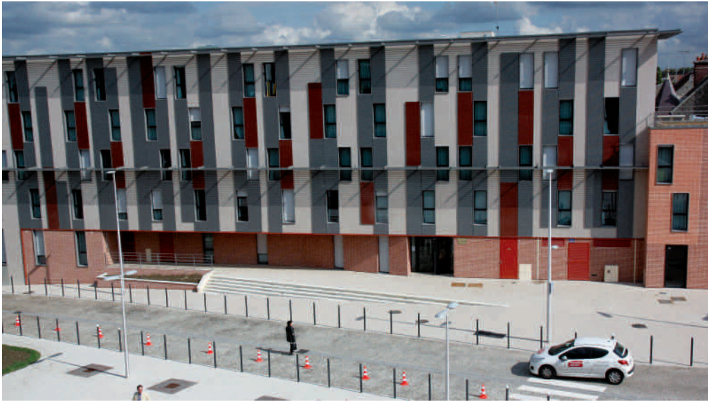
La Ruche, la plus récente réalisation de l'ALESC, près du Pont Neuf.
