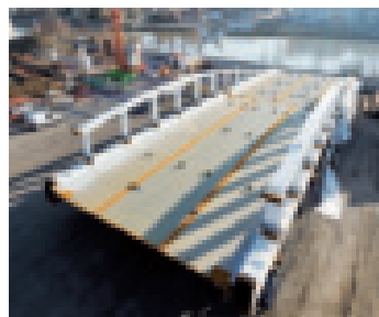
Une partie du tablier a été livrée sur le chantier.
