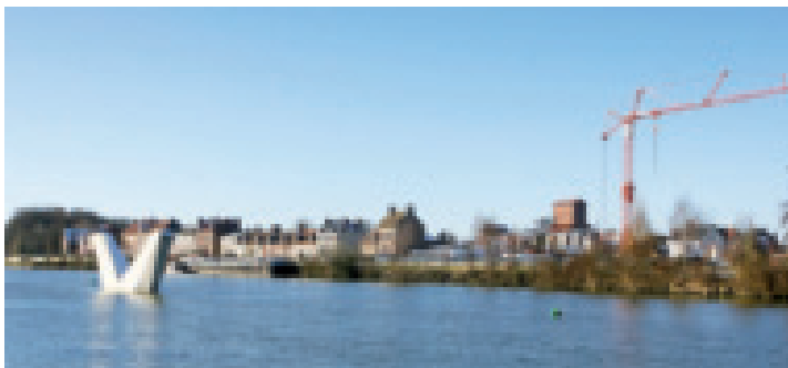
Août 2011, mise en circulation du nouveau pont.
