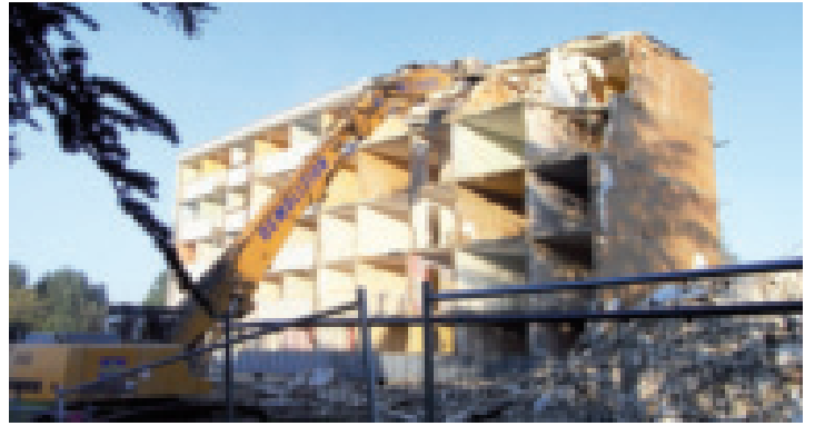
Démolition de la résidence Pierre Loti.
