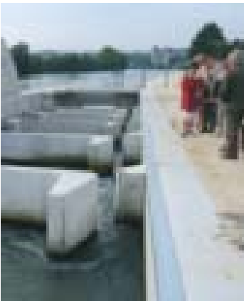
Premiers coups de pioche pour la reconstruction du barrage de Venette et l'iréalisation du bassin d'orages de la rue de l'Oise.
