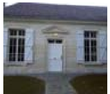
La "petite hutte" du Clos Pompadour entièrement rénovée.
