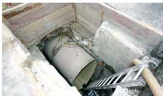
Le chantier s'est limité extérieurement à une fosse de descente, les anneaux de résine synthétique ont ensuite été glissés dans l'ancienne conduite.
