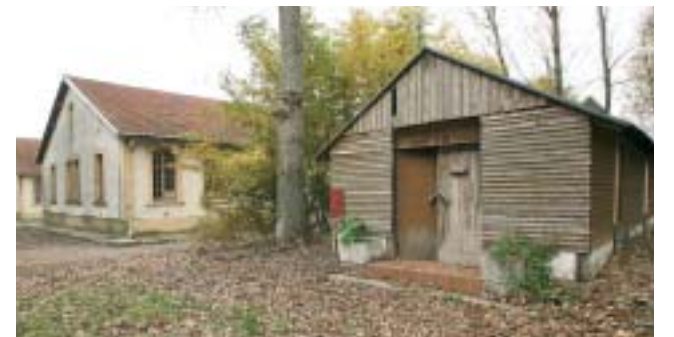
Les bâtiments anciens accueilleront les salles du musée.
