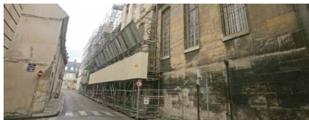
Les échafaudages recouvrent les murs du Palais de Compiègne pour d'importants travaux de rénovation de la toiture.
