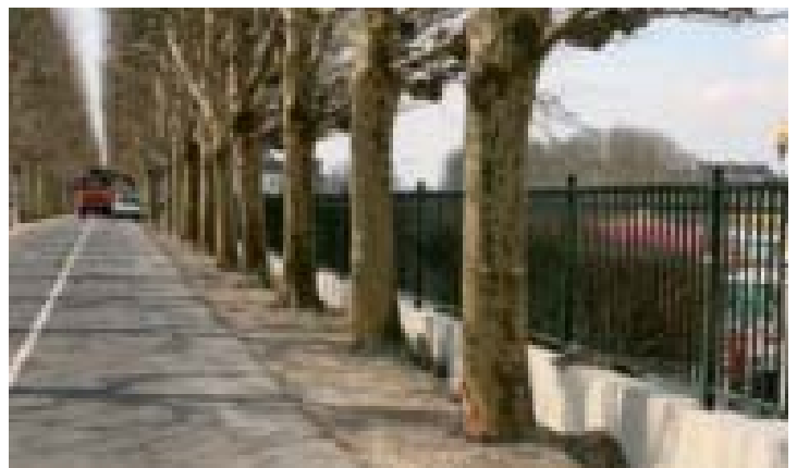
Installation d'une clôture, cours Guynemer.
