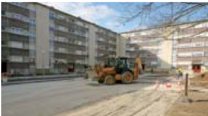
Le square Lyautey en travaux.
