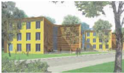
La future résidence étudiante sera située à proximité du rond-point de Mercières.
