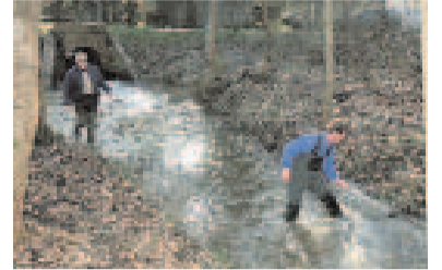
Le premier acte de ce chantier de cinq ans concerne le ru de Berne.
