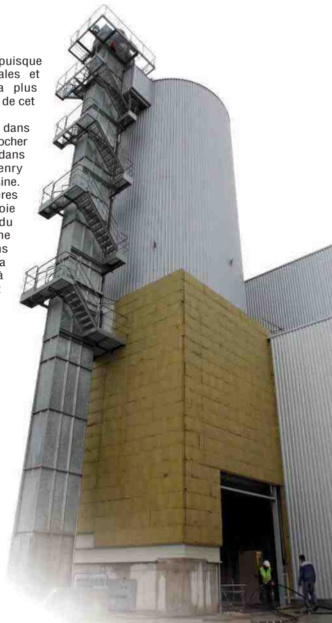
La centrale à béton
