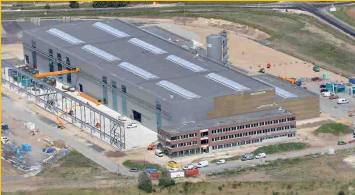
L'usine ENERCON de Longueil-Sainte-Marie en cours de construction
