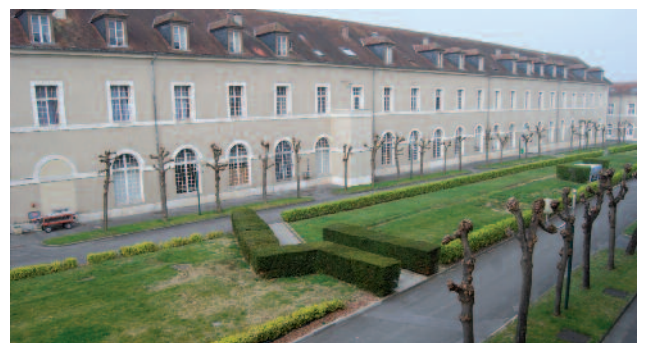
> Ce bâtiment de l'ancienne Ecole d'Etat-Major devrait accueillir des espaces de formations et des bureaux
