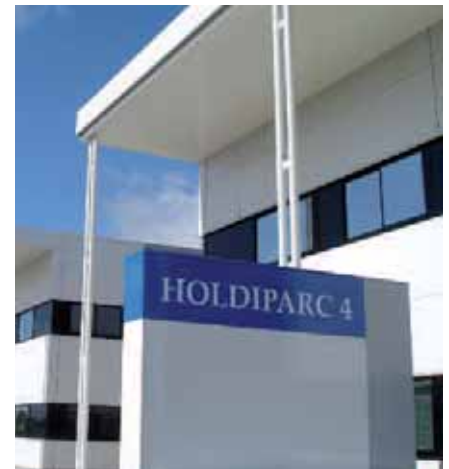
Les bâtiments Holdiparc à La Croix Saint Ouen
