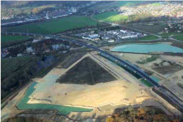
> Bassin d'atténuation des crues à Choisy-au-Bac
