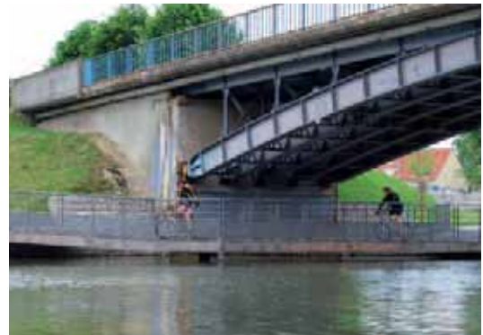
> Aménagement de la piste cyclable sur pilotis à Choisy-au-Bac
