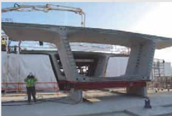
Les voussoirs sont des blocs de 50 tonnes construits sur place puis assemblés pour former le tablier
