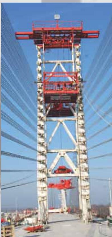
Le mât de haubanage mesure 22 mètres. Il permet d'assembler les voussoirs
