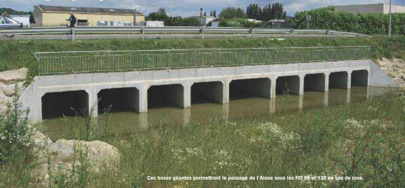
Ces buses géantes permettront le passage de l'Aisne sous les RD 66 et 130 en cas de crue.
