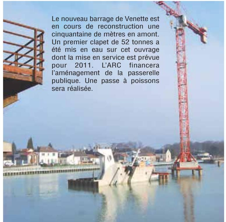
Le nouveau barrage de Venette est en cours de reconstruction une cinquantaine de mètres en amont. Un premier clapet de 52 tonnes a été mis en eau sur cet ouvrage dont la mise en service est prévue pour 2011. L'ARC financera l'aménagement de la passerelle publique. Une passe à poissons sera réalisée.
