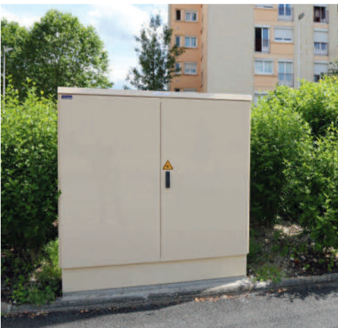
Au total, 55 armoires seront installées sur le territoire de Compiègne.
